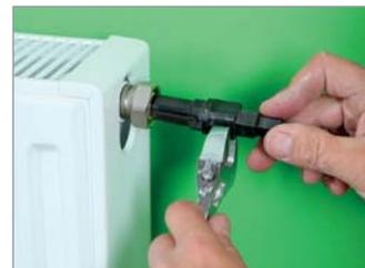
L'étanchéité des raccords à portée conique du robinet d'arrivée et du retour chauffage est assurée avec de la filasse et de la pâte.
