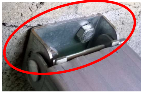
Fixation du rail au mur
