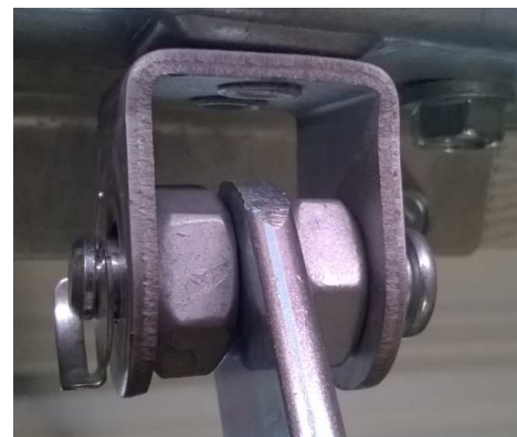
Exemple de montage bielle/attache avec les 2 écrous
